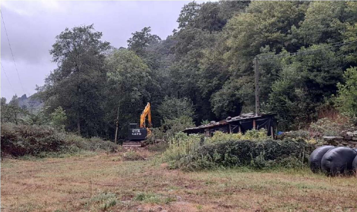
Ejecución de los trabajos: reapilado mecanizado (Riluena)
