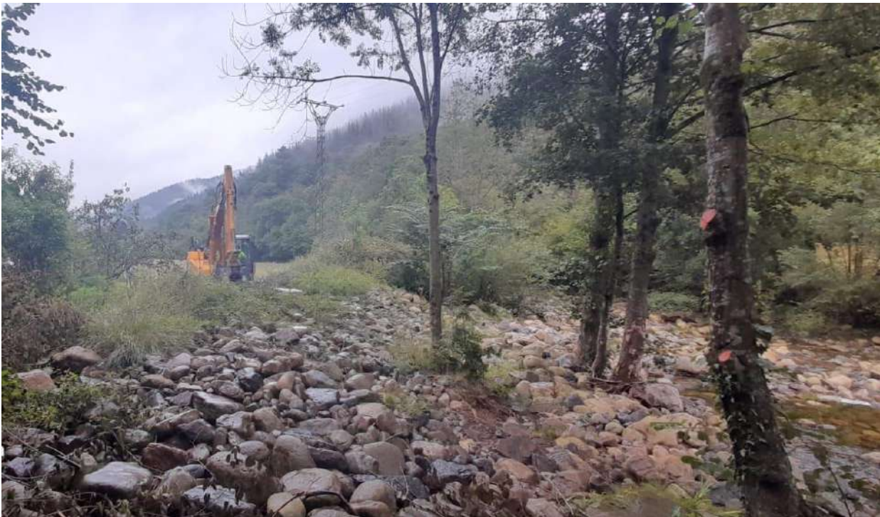
Ejecución de los trabajos: reapilado mecanizado (Riluena)
