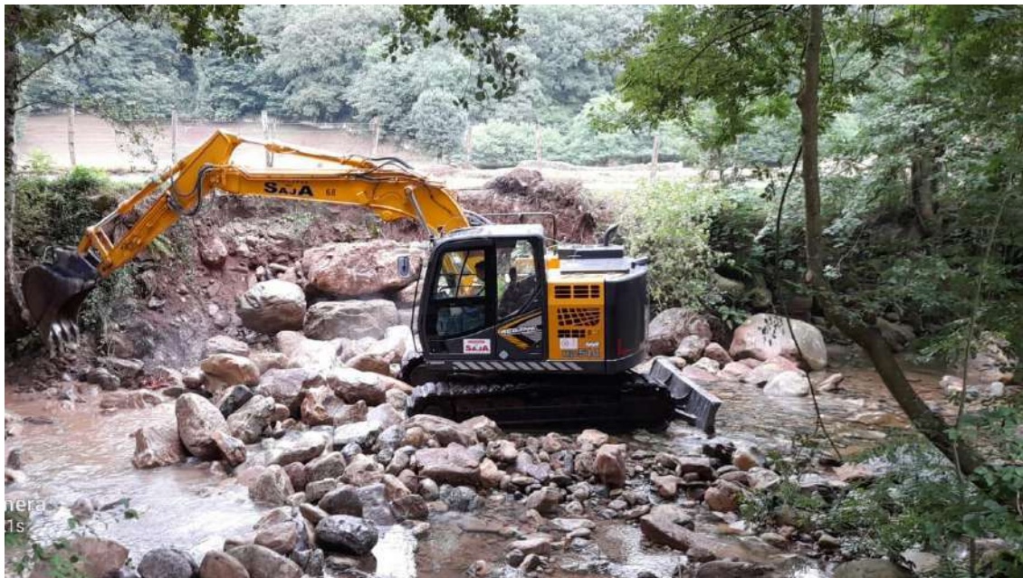
Ejecución de los trabajos: reapijado mecanizado (Bustasur)
