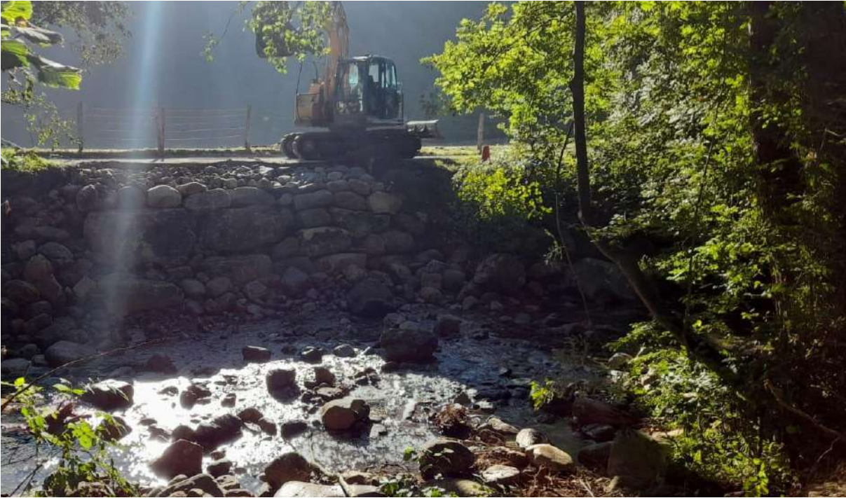
Ejecución de los trabajos (Bustasur)
