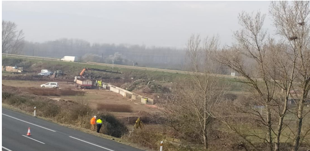
Reposición de servicios afectados (Acequia en Villamediana de Iregua en enlace LR-250).
