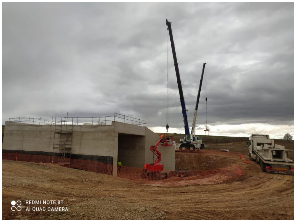
Ejecución de estructuras (Ejecución paso inferior en Conexión 1).
