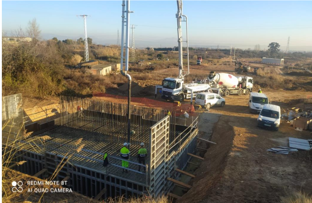
Ejecución de estructuras (Hormigonado de zapata en enlace N-111).
