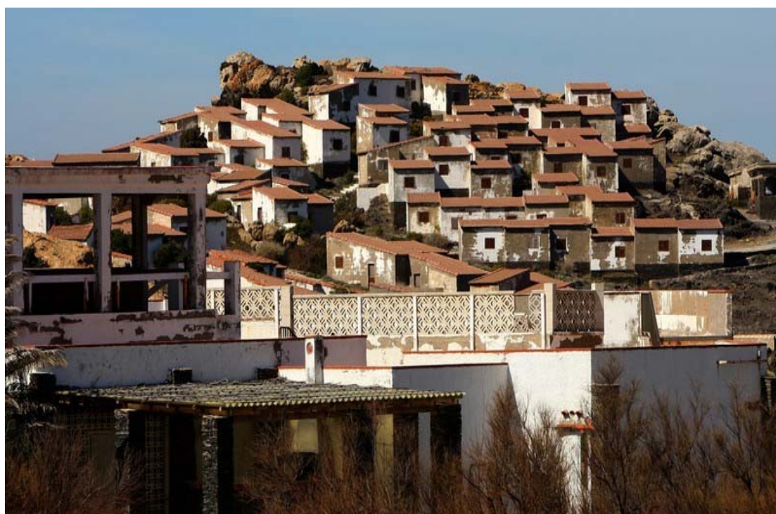
Vista parcial de las edificaciones que se van a derribar en el Club Mediterranèe
