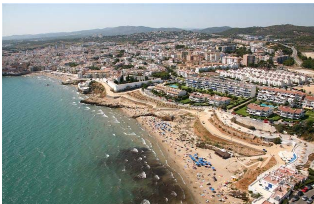
Vista aérea de la zona de la actuación en Sitges (Barcelona)
