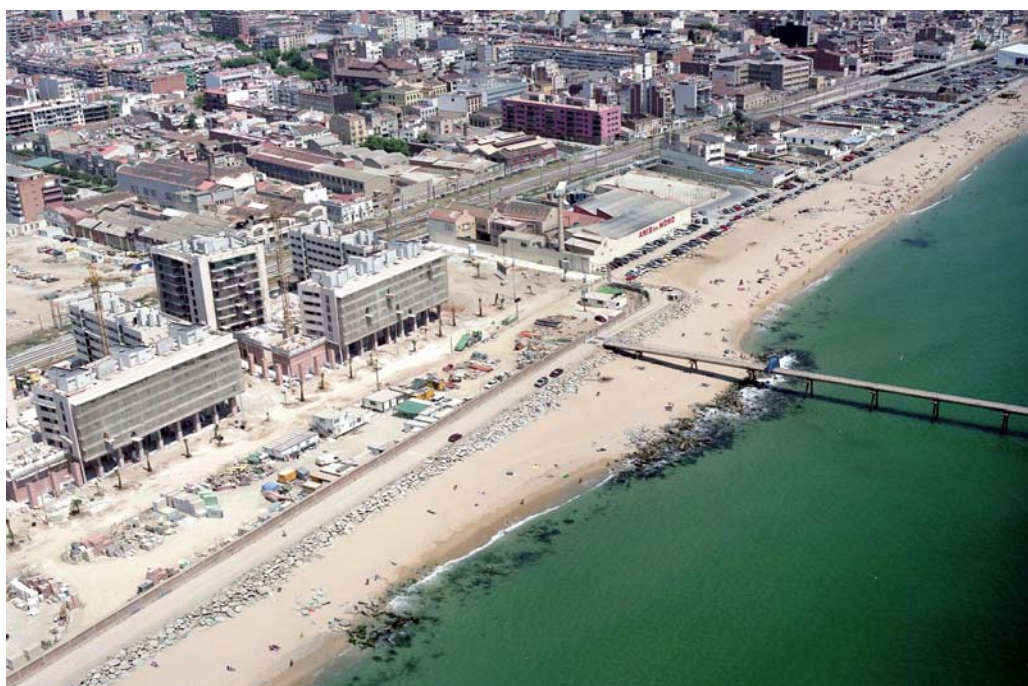
Vista del paseo marítimo de Badalona (Barcelona)
