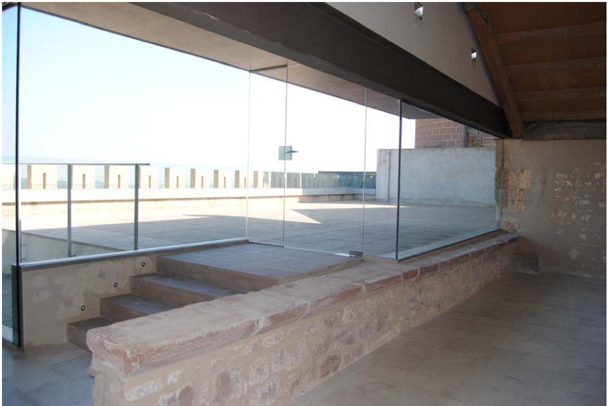
Coberta-mirador del castell de Castelldefels
