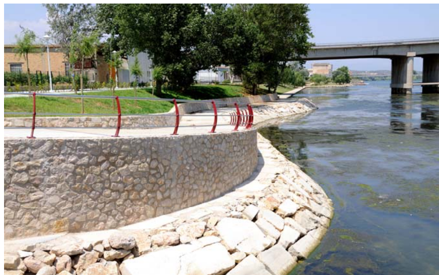
Vista de un tramo del nuevo paseo fluvial de Amposta
