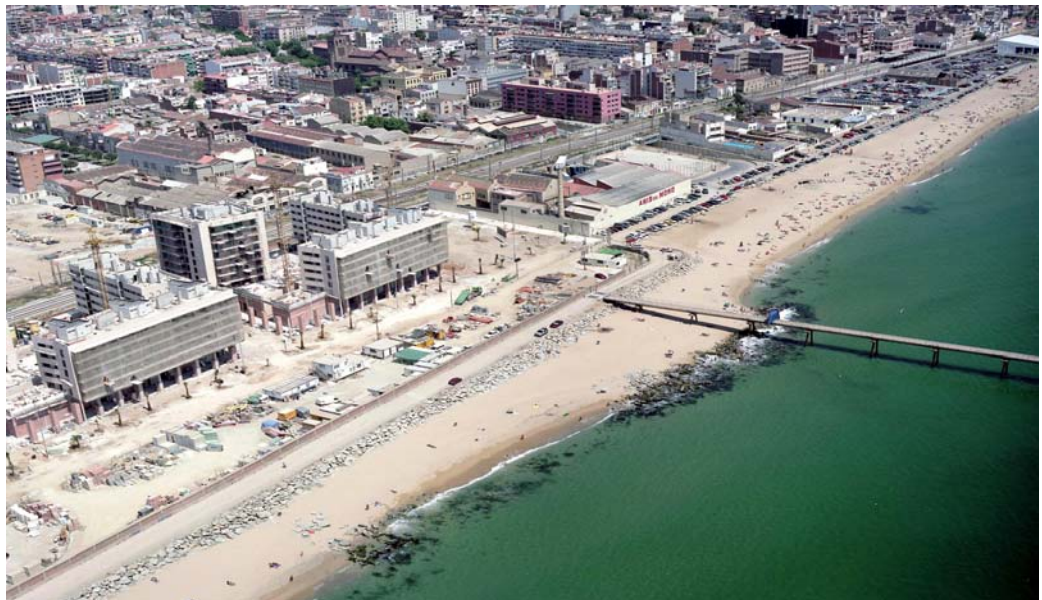
Vista del paseo marítimo de Badalona (Barcelona)
