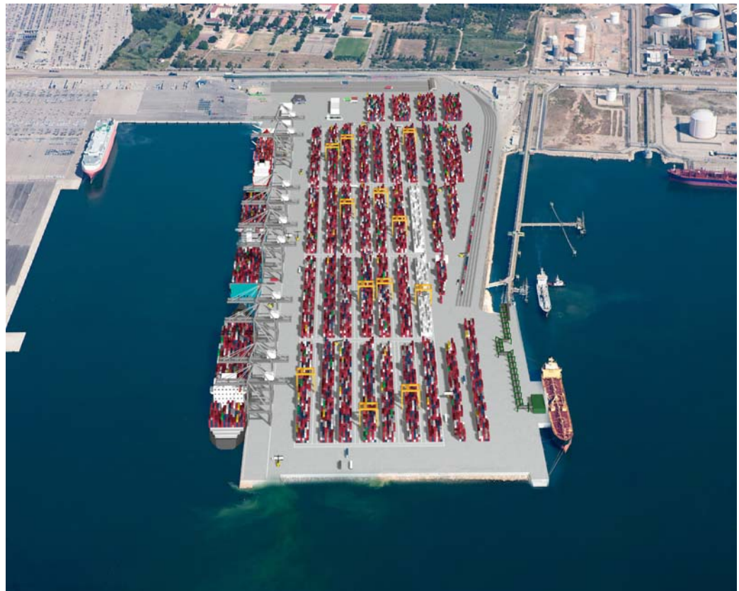
Muelle de Andalucía. Recreación virtual de la situación final prevista una vez concluidas todas las obras.
