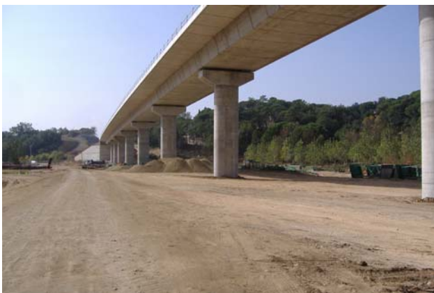
Viaducto sobre la Riera de Santa Coloma (590 m)
