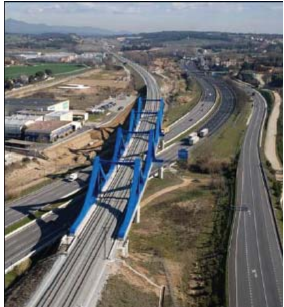
Viaducto de Llinars (574 m)
