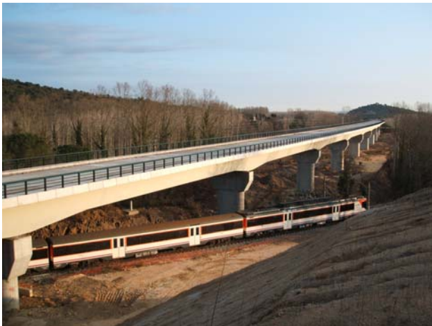
Viaducto de José Antonio Fagúndez Vargas (691 m)
