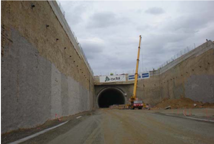
Obras del túnel de Figueres (1.740 m)
