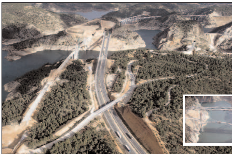
Arco-puente del AVE sobre el embalse de Contreras
