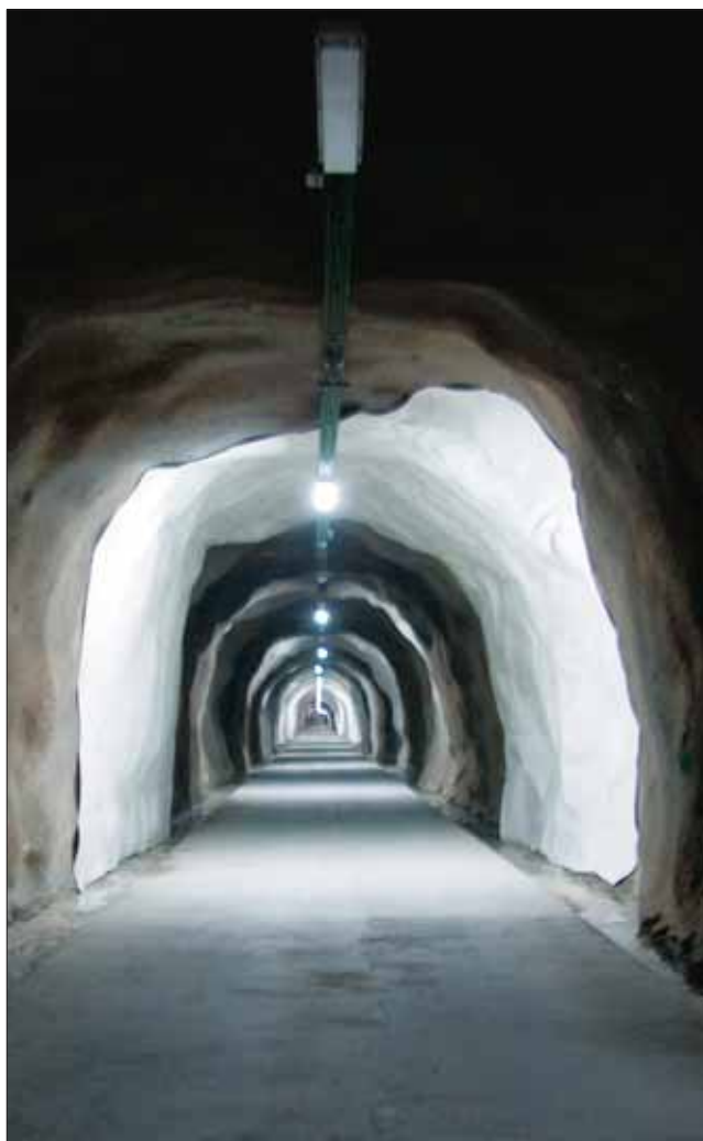
De arriba abajo, la sinuosa carretera antigua sobre la nueva boca e imagen de la galería de emergencia. Foto principal, boca del lado soriano.
