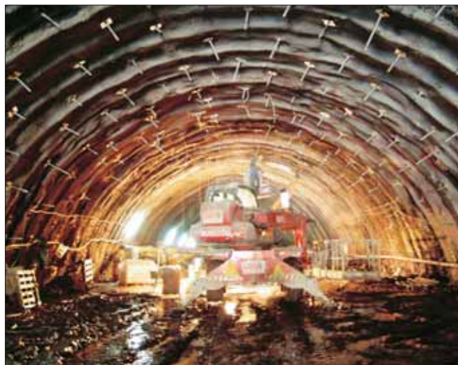
► Imágenes de los trabajos llevados a cabo en el interior del túnel, siguiendo el método de perforación y voladura, y de las filtraciones de hielo halladas.
