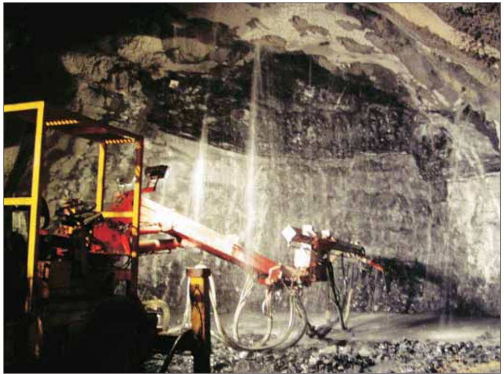
► Imágenes de los trabajos llevados a cabo en el interior del túnel, siguiendo el método de perforación y voladura, y de las filtraciones de hielo halladas.
