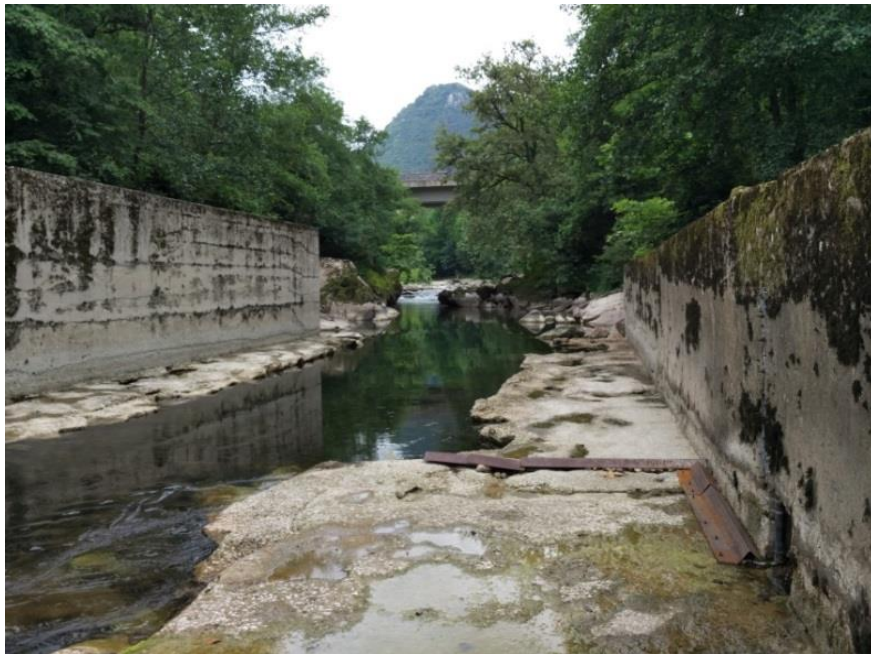
Estación de aforos del río Pas en Puente Viesgo
